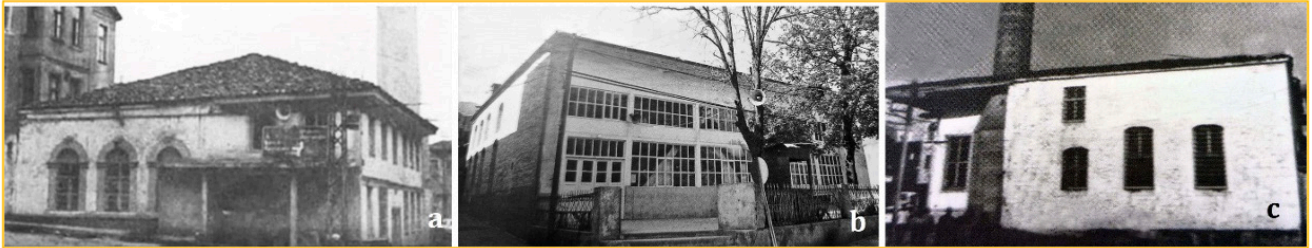
Foto-10 Yıkılan Osmanlı dönemi camileri; a) Gözaçan Cami; b) Pazarkapı Cami; c) Tabakhane Cami
